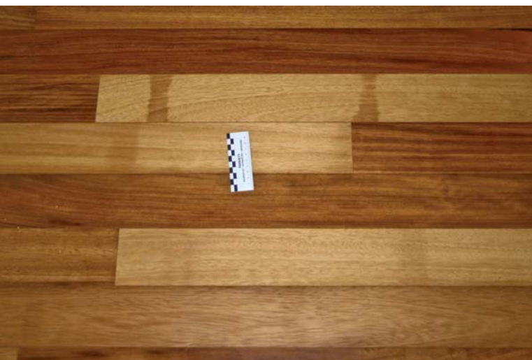
Zdj. 1. Posadzka z drewna iroko z widocznymi ciemniejszymi śladami po przekładkach.
