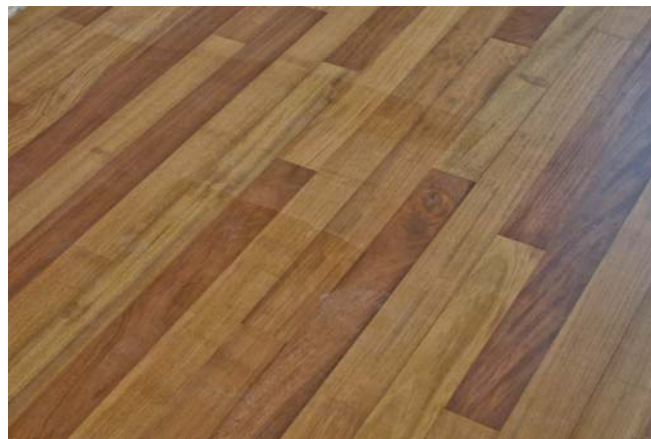
Zdj. 2. Przebarwienia posadzki z iroko po nałożeniu lakieru wodnego bezpośrednio na drewno
